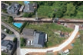
道路災害復旧工事
